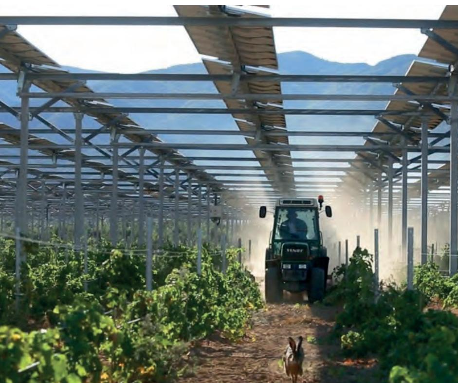
Abb. 49: Hoch aufgeständerte Anlage mit durchgängigen Modulreihen. © Sun'Agri
