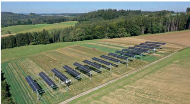
Abb. 56: Agri-PV-Anlage in Heggelbach mit einer Leistung von 194 kW<sub>p</sub> auf etwa einem Drittel Hektar. © Fraunhofer ISE
