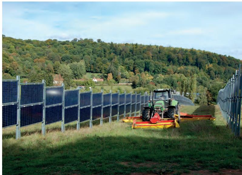
Abb. 36: Vertikal errichtete, bifaziale Module im Solarpark in Eppelborn-Dirmingen, Saarland, mit 2 MW<sub>p</sub> Leistung, errichtet von Next2Sun. © Next2Sun GmbH
