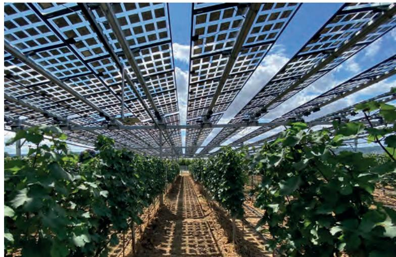
Abb. 54: Schattenwurf der lichtdurchlässigen PV-Module über Weinreben © HS Geisenheim
