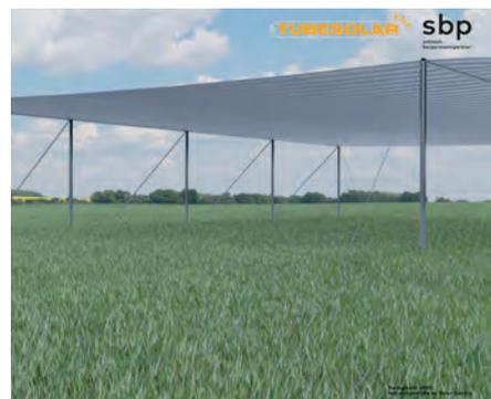
Abb. 48: Hoch aufgeständerte Anlagen mit schmalen PV-Modulen in Italien. © REM Tec
