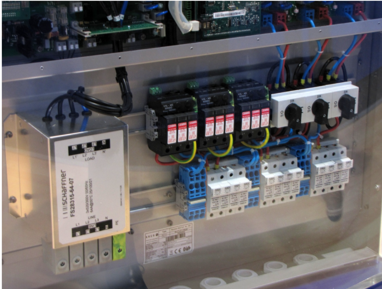
Kaco 39 kW AC Schaffner Filter DC SPD, Sicherungen und DC Schalter
