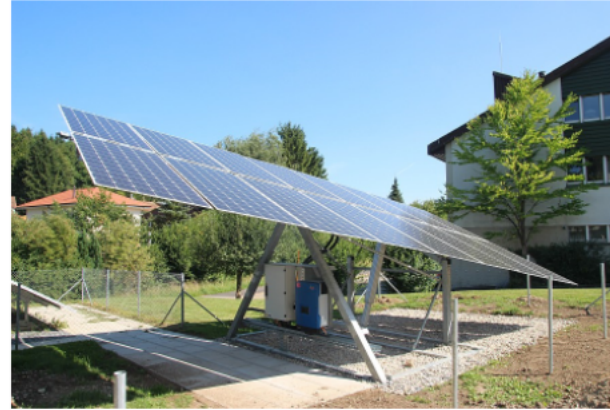
Drehbare Solaranlage 8m lang 4m breit, 16 Module monokristallin 300W
