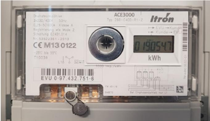
Abbildung 27: Digitaler Zweirichtungszähler
