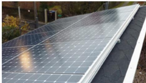
Abbildung 36: Montage auf Bitumenschindeln
