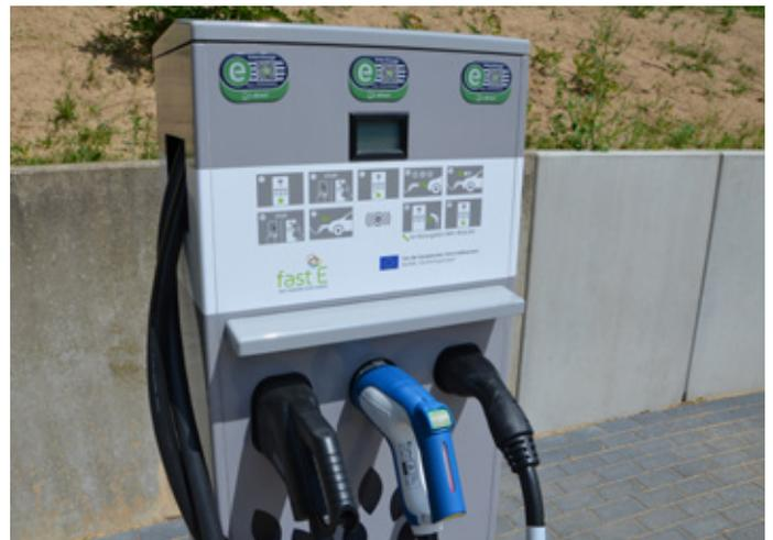
Abbildung 102: Schnellladestation mit verschiedenen Ladesystemen
