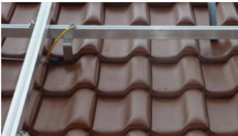
Abbildung 35: Anschluss Potentialausgleich am Befestigungssystem
