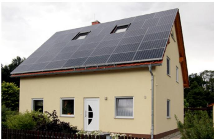
Abbildung 109: Optimale Dachausnutzung trotz Dachfenstern
