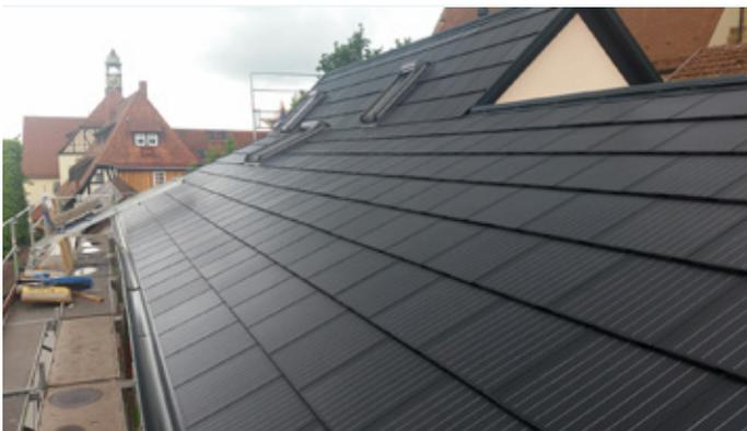
Abbildung 46: Solardachziegel in Flachziegeloptik
