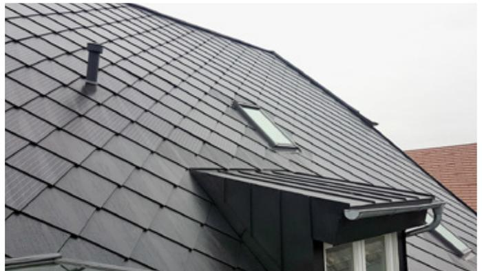
Abbildung 47: Solardachziegel in Dachschieferoptik
