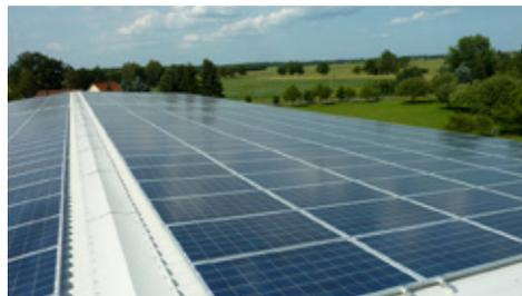
Abbildung 39: Dachparallele Montage auf Trapezblech
