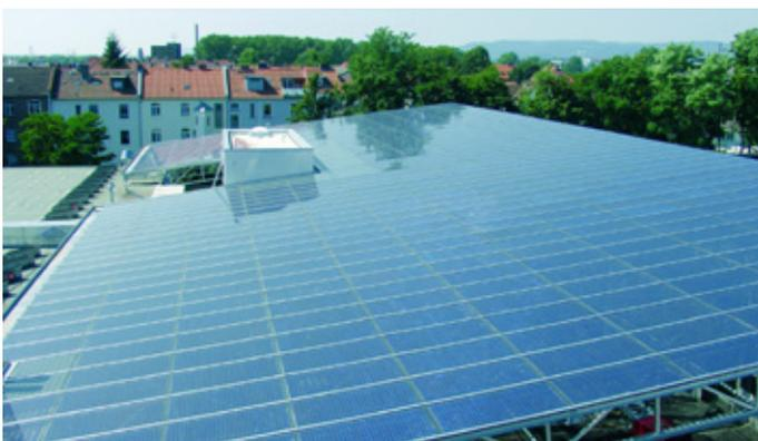
Abbildung 52: Überdachung mit Solar-Glas
