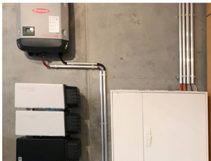
Abbildung 73: Modular erweiterbares Stromspeichersystem
