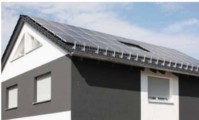
Abbildung 29: Aufdach-Montage eines Solargenerators
