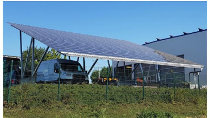
Abbildung 55: Solar-Carport mit Dünnschicht-Modulen
