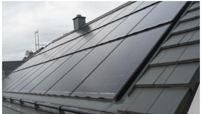
Abbildung 45: Fertige Indach-Anlage mit Glas-Glas-Modulen
