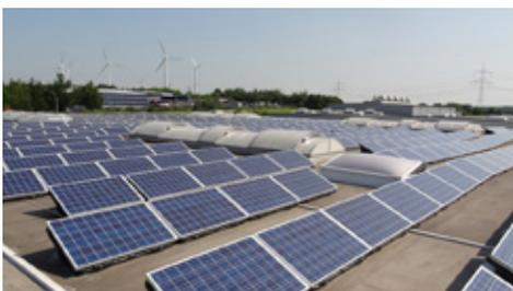
Abbildung 41: Aufgeständerte Montage mit Kunststoffwannen
