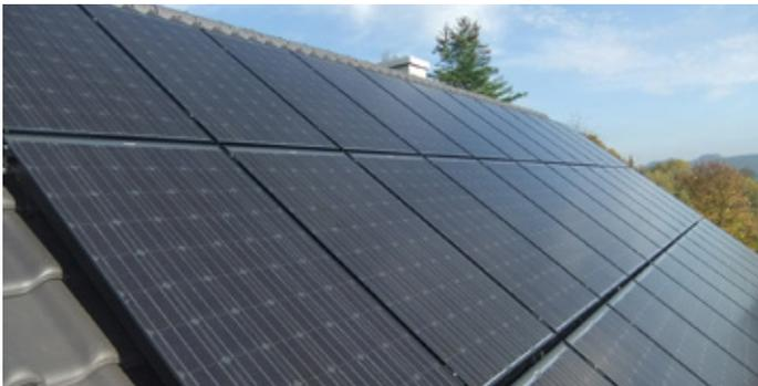
Abbildung 11: Aufdach-Anlage mit monokristallinen Dickschichtmodulen
