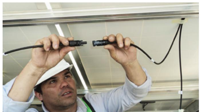
Abbildung 24: Verbindung von Solarmodulen mit MC4-Steckverbinder
