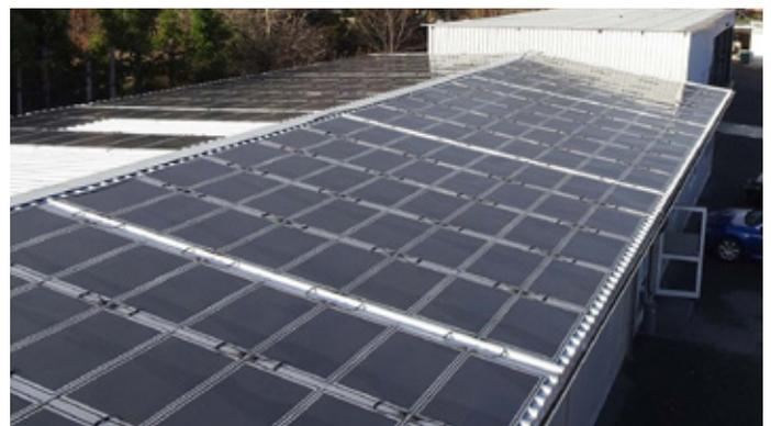
Abbildung 19: Aufdach-Anlage mit Dünnschichtmodulen (CIGS)
