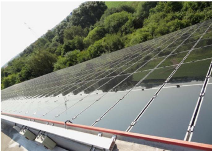
Abbildung 18: Aufdach-Anlage mit Dünnschicht-Modulen (CIS)
