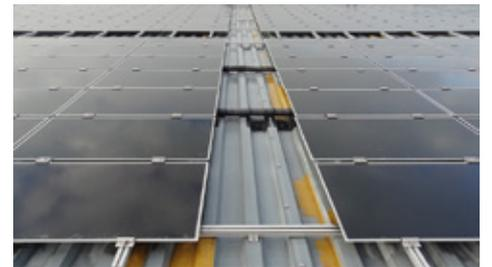
Abbildung 37: Montage auf Trapezblechdach
