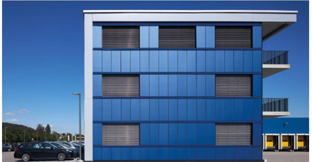
Abbildung 49: Fassadenanlage mit blauen Dünnschichtmodulen
