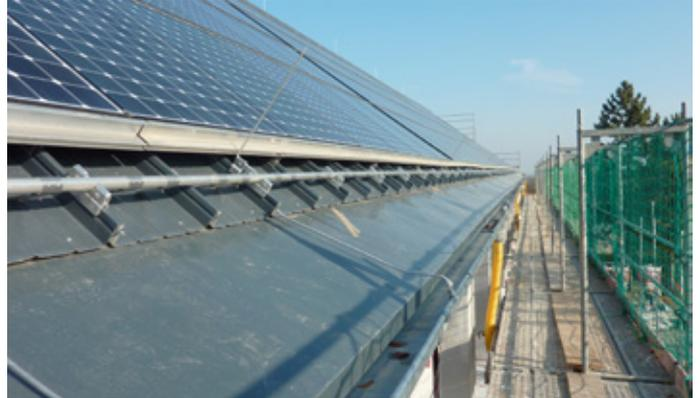
Abbildung 107: Installation von Photovoltaik- und Blitzschutzanlage
