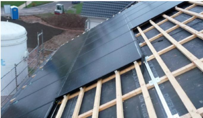
Abbildung 44: Indach-Montage mit Glas-Glas-Modulen
