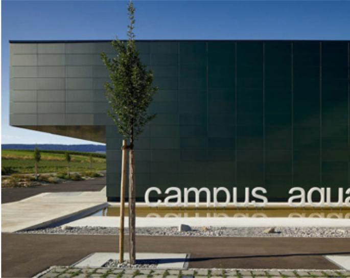
Abbildung 17: Fassade mit grünen Dünnschichtmodulen (CIS)
