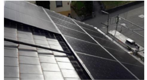
Abbildung 34: Modulbefestigung mit K2 Systems Einlegesystem
