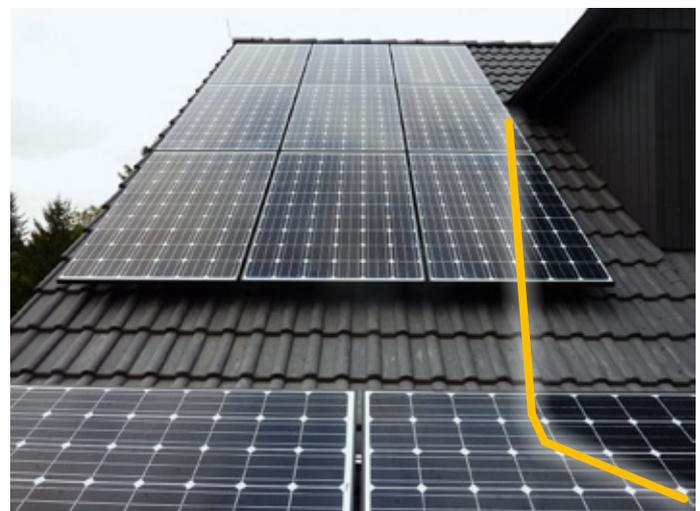
Abbildung 65: Verlauf des Schattens (gelbe Linie) durch eine Dachgaube
