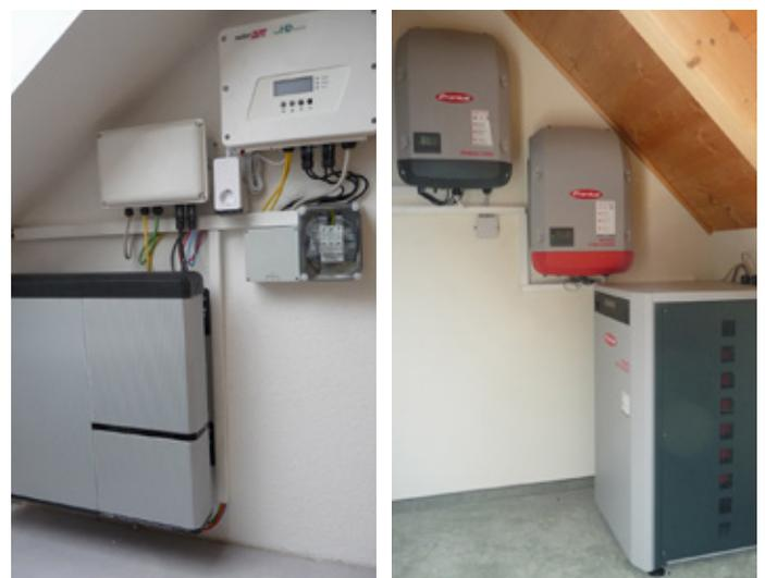
Abbildungen: 76/77: Installierte Solarstrom-Speichersysteme
