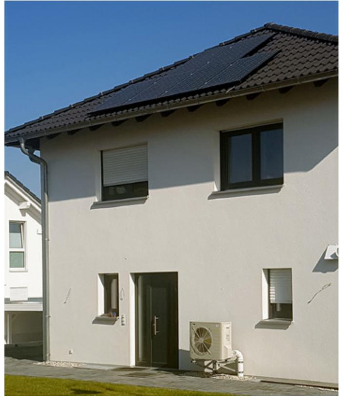
Abbildung 83: Kombination Luft-Wasser-Wärmepumpe mit PV-Anlage
