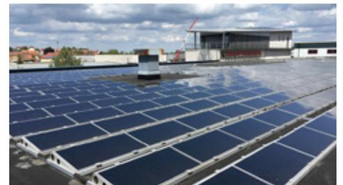
Abbildung 40: Aufgeständerte Montage mit Kunststoffwannen
