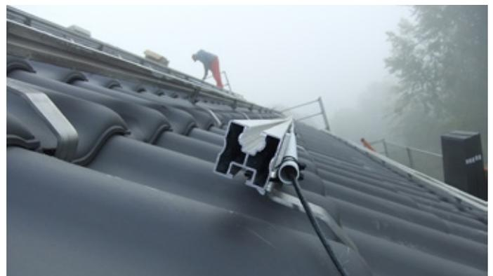
Abbildung 23: Verlegung von Solarkabeln in Schutzrohren
