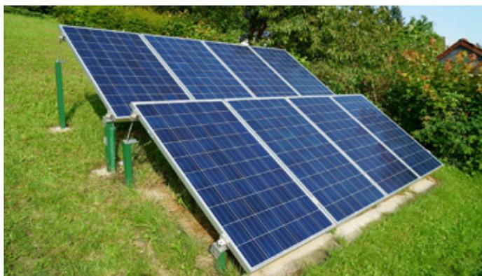
Abbildung 58: Kleine aufgeständerte Freilandanlage für private Nutzung
