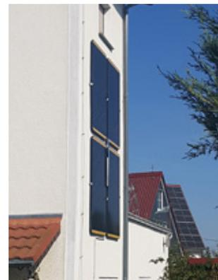
Abbildung 57: Mini-PV-Anlage an einer Fassade
