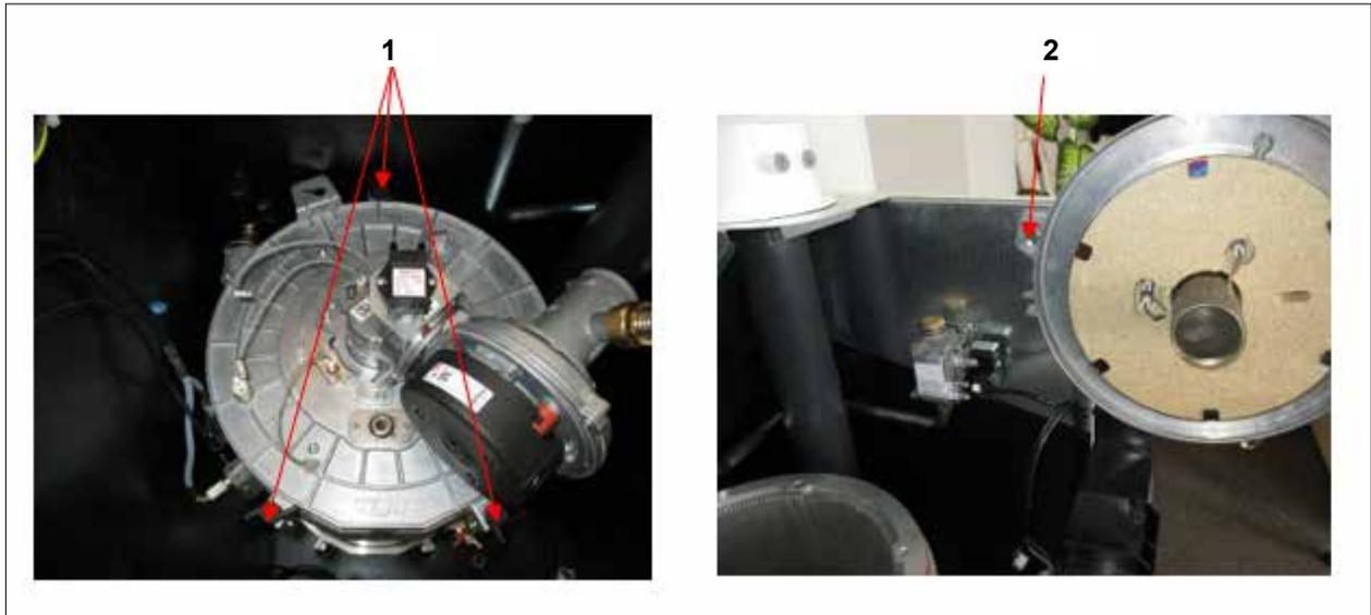
**Abb. 5.11 Brennerdeckel Wartungsposition**
