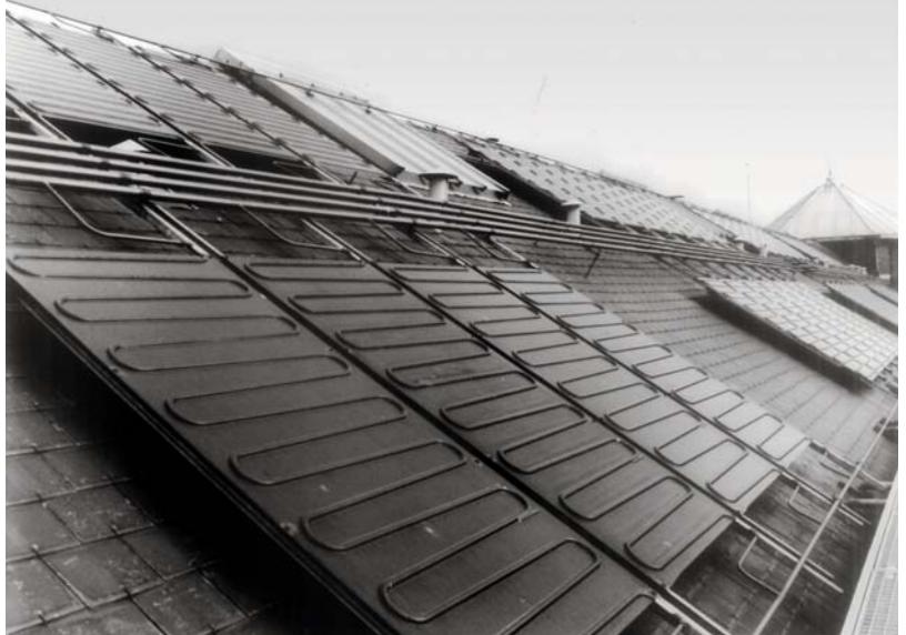
Abb. A.4.6-1 Wärmequelle unverglaste Absorber
