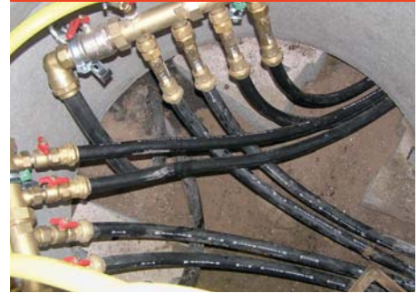
Abb. A.4.1–8 Soleverteiler bei Erdsonden
