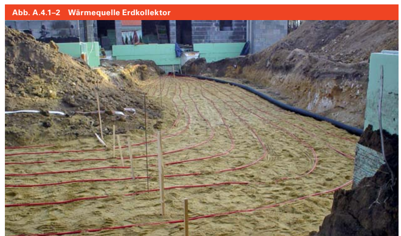
Für den Erdkolektor werden Kunststoffrohre flächig verlegt und mit 1,2 bis 1,5 m Erdreich bedeckt.
